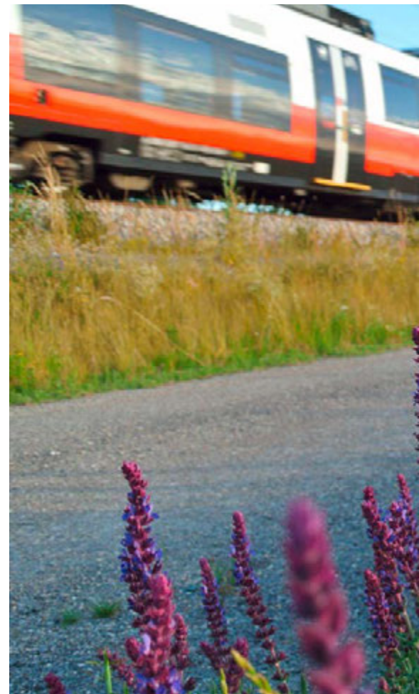
BAU- UND ERHALTUNGSMASSNAHMEN an der Schiene
