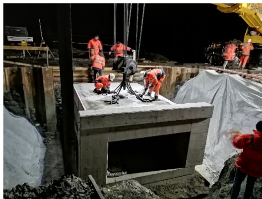
Foto links: Brückeneinhub Riedlinggraben © WH Ingenieure/Holzmann
