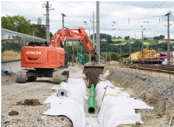
Foto: Unterbauarbeiten ©ÖBB-Duchatzek
